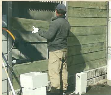
悪くなったところはDIYで入れ替え
